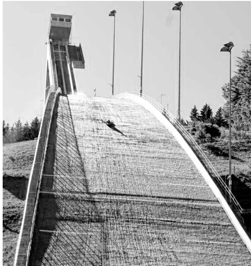
... die Einsiedler Schanzen hinunter und erreichen Tempi bis zu 100 km/h.
